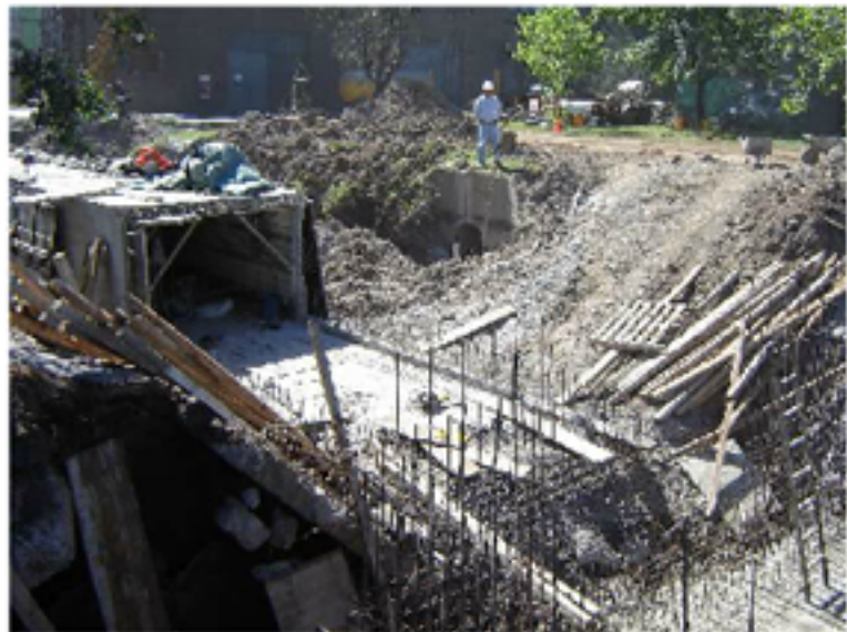
Entubamiento de Canal (Siderca - Campana / Pcia. de
